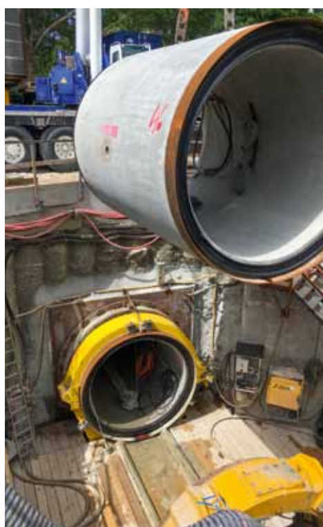
Mit ihren Spezialbohrern baut Arkil Spezialtiefbau Minitunnel von bis zu drei Metern Durchmesser.
